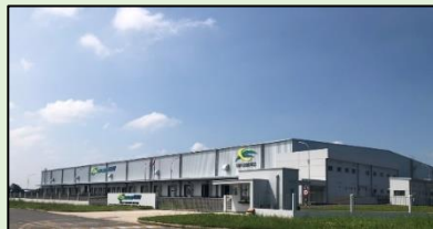
第三倉庫外観(建設中)
