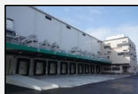
HN東北支店第二センター増築棟
