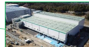
HN箕面森町新拠点(建設中)
